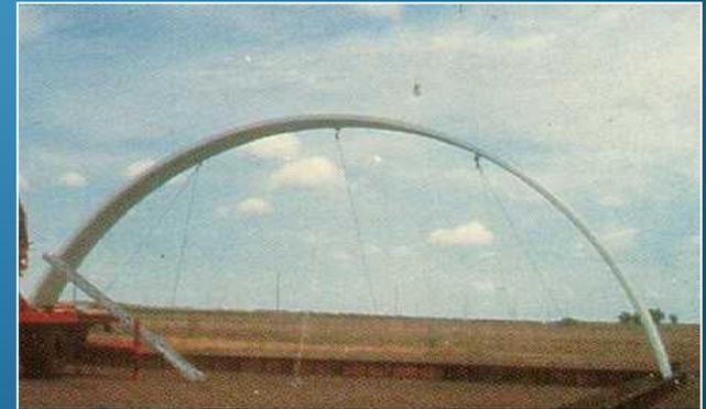
Este tipo de cubierta se desplanta al nivel del terreno sobre un canal de cimentación corrida ofreciéndole la ventaja de que la lamina de la cubierta puede ser utilizada como muro y cubierta a la vez.
